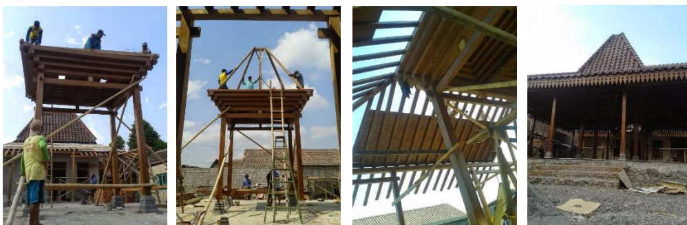
Gambar 1.7. Proses Pembangunan Joglo menggunakan Material Aslinya, yaitu Kayu Jati Jepara
