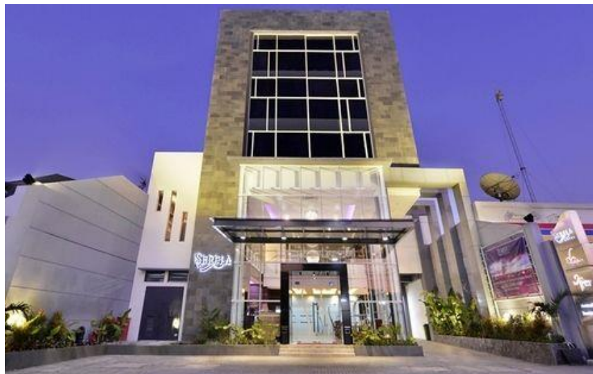
Gambar 1.8 Hotel Serela di jalan Kelenteng
