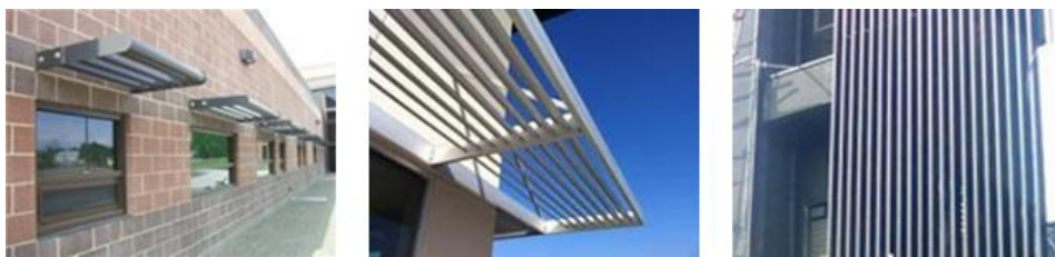
Gambar 6.1. Contoh Penerapan Peneduh Eksternal Kisi-Kisi Material Baja (Sumber: Sun Control and Shading Devices, https://www.wbdg.org/resources/sun-control-and-shading-devices diakses pada tanggal 15 Mei 2018)
