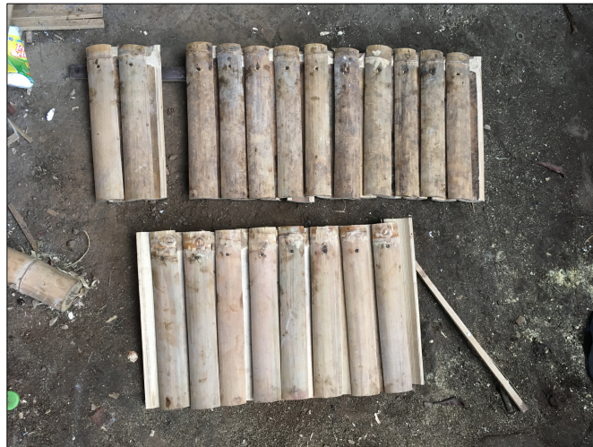
Panel sirap bambu yang masih dipaku ke bilah bambu
