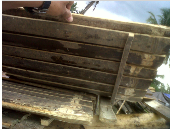
Sambungan rusuk panel ke reng Sumber: Dokumentasi Eugenius Pradipto
