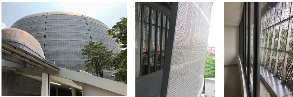
Gambar 1.2 Gedung C UMN dan fasad double skin aluminium
