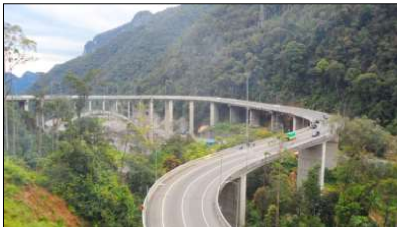
Gambar 1.1. Jembatan Layan Sitinjau Laut
