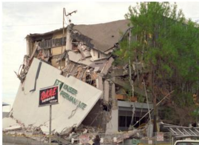
Gambar 1.1 Keruntuhan struktur akibat kegagalan hubungan balok kolom, Bangunan Kaiser Permanente, Gempa Norridge, 1994. Foto oleh G. Edstrom.
