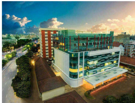
Gambar 1-2 Proyek Rumah Sakit “STC” di Kota Jakarta
