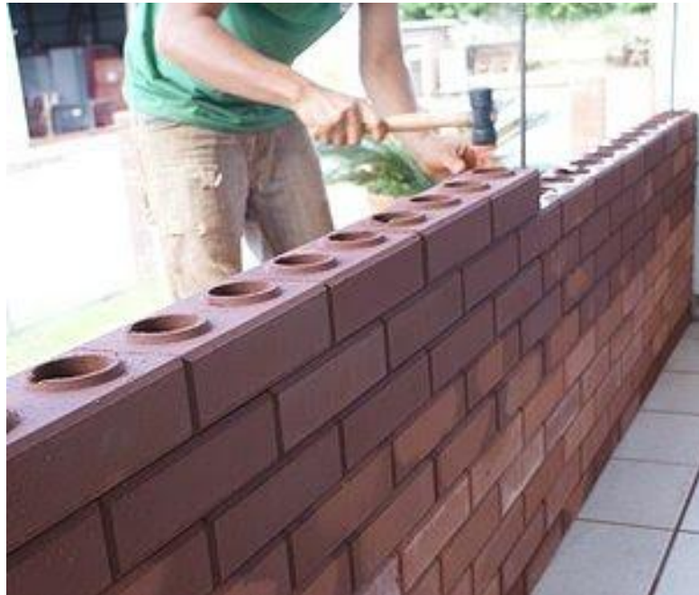
Gambar 1 Susunan Batu Bata Tanah Interlocking
