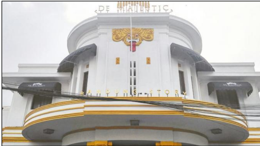
Gambar 1.6. Gedung Majestic pada tahun 2017 (Sumber: https://demajesticbandung.com/ , 2017)
