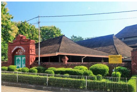
Gambar 1.2 Bangunan Masjid Agung Sang Cipta Rasa Cirebon
