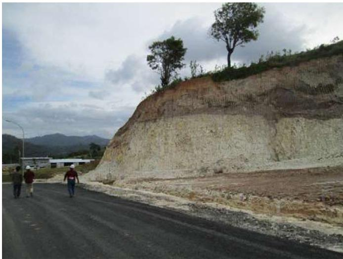
**Gambar 1.1** Lapisan Tanah pada Lereng CitraGarden, Lampung
