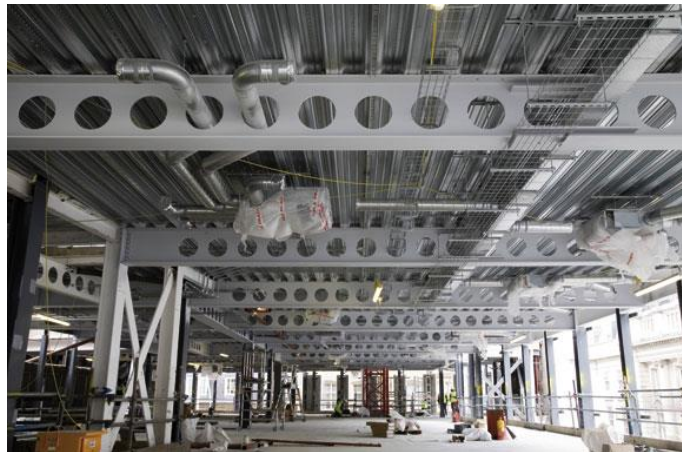
Gambar 1.1 Jalur Perpipaian pada Balok Baja Berlubang Lingkaran
