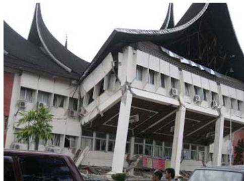
Gambar 1.3 Kegagalan pada SBK eksterior (Gempa Padang, 2009)
