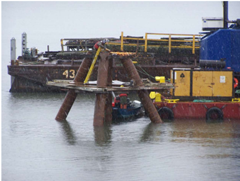
Gambar 1 Aplikasi Batterpile untuk memikul beban horizontal
