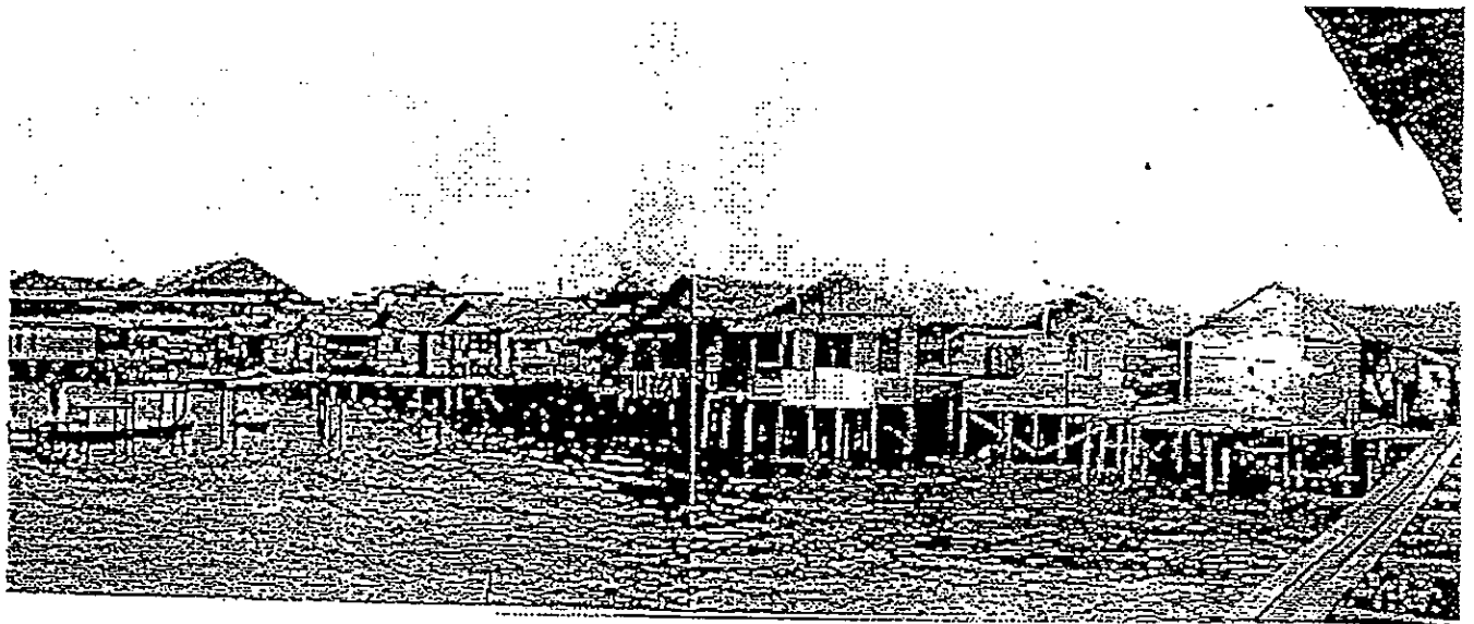
Gambar – 4 Situasi Kondisi Awal Kampung Beting
