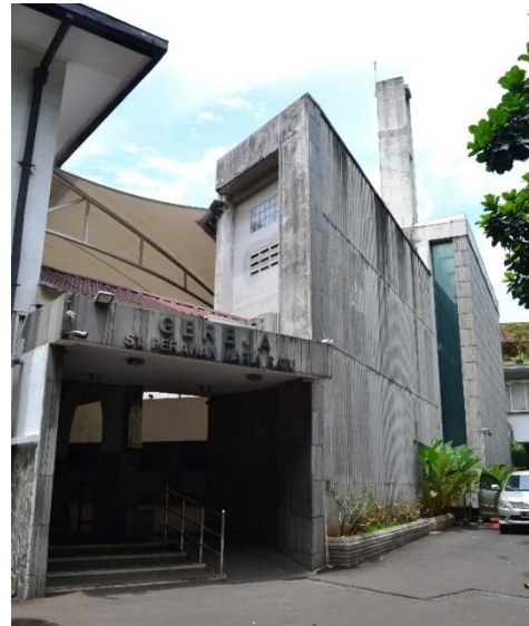
Gambar 1.4. Bangunan Baru dilihat dari Entrance Kompleks Gereja
