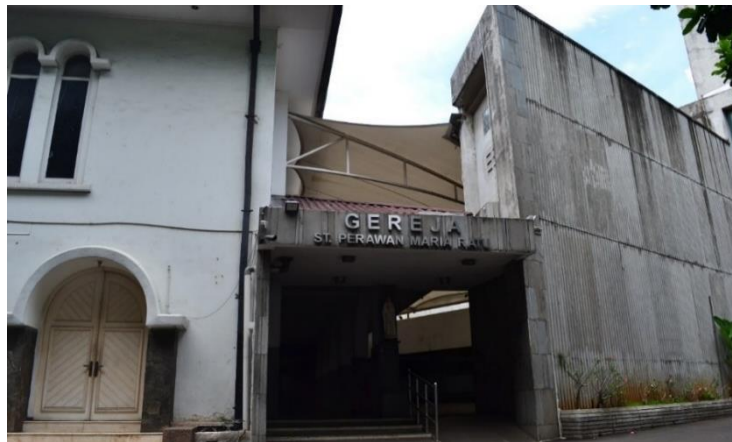
Gambar 1.1 Bangunan Lama (kiri) dan Bangunan Baru (kanan)
