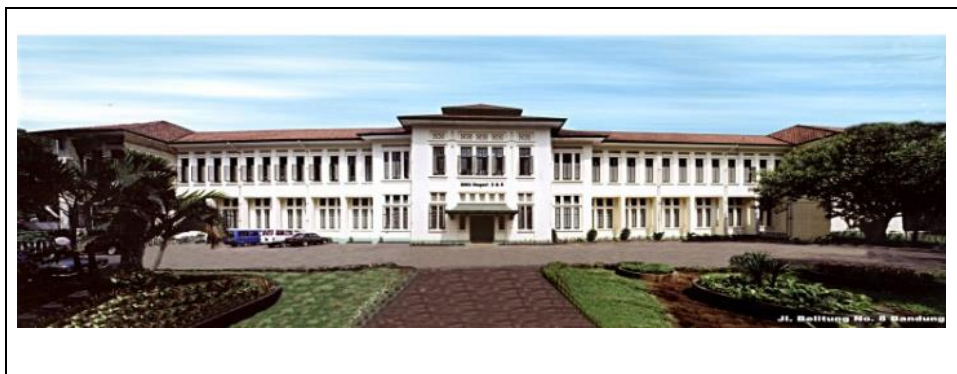
Gambar 1.3 Gedung SMAN 3 dan 5 Bandung 2007. (Sumber : www.youthmanual.com diunggah pada tanggal 11 Februari 2017)
