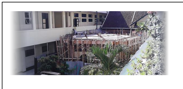
Gambar 1.2 Pembangunan Mushola SMAN 5 Bandung Sumber : sman5bandung.sch.id
