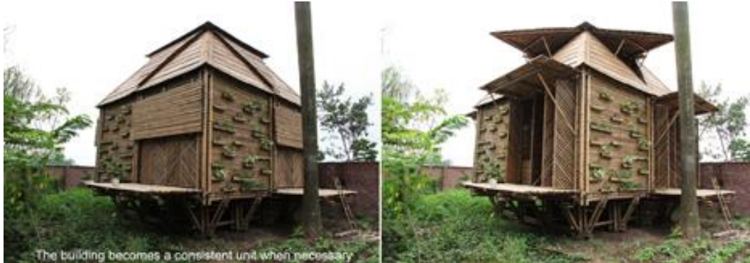
Gambar 1.4 Bangunan Blooming Bamboo Home (a)Keadaan bangunan ketika dilipat (b) Keadaan bangunan ketika dibuka Sumber: www.dezeen.com , diakses 1 Februari 2017
