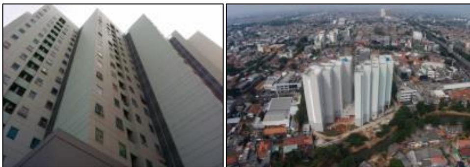
Gambar 1.1. Eksterior Bangunan Rusun Jatinegara
