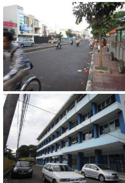
Figur 4. Elemen dan Suasana di Depan Pagar dan Depan Fasad Bangunan Sekolah SDK 6 BPK. Penabur
