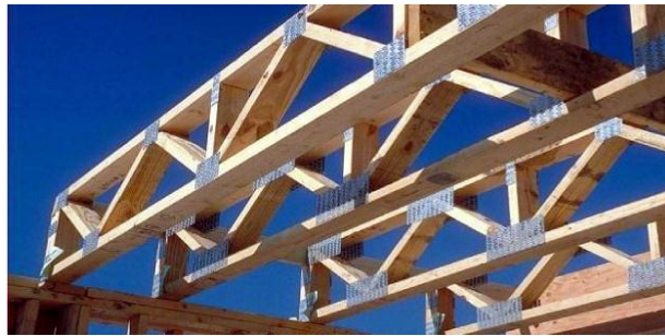
Gambar 1.1 Contoh struktur rangka batang kayu pengganti balok
