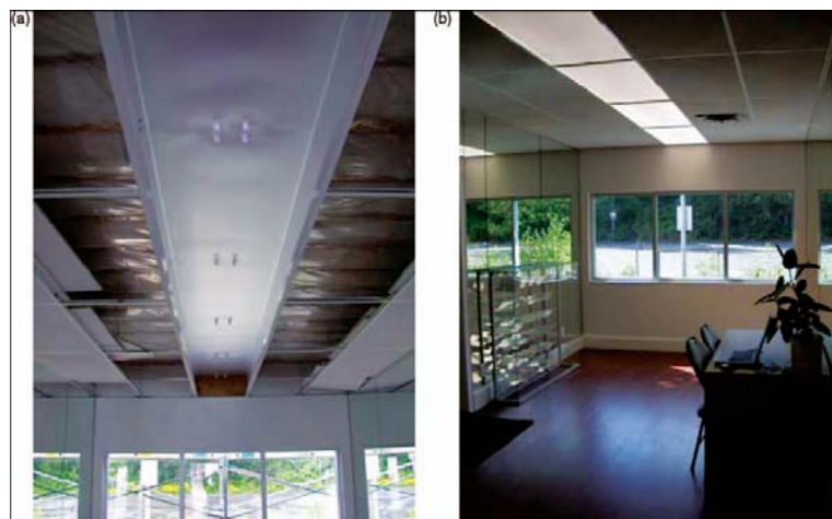
Gambar II.35 Pemasangan armatur cahaya pada plafond (a), Kondisi ruang dengan armatur cahaya sebagai outlet (b)
