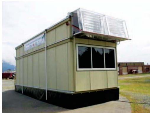
Gambar II.36 Pemasangan sistem canopy sebagai inlet pada ruang simulasi
