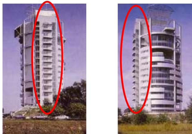
Gambar 3.1.16 Tampak depan dan samping core pada sisi timur bangunan.
