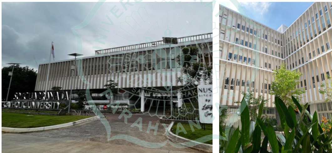
Gambar 1. 1 Bangunan Gedung Innovative Program Cluster (IPC) Kampus Unika Soegijapranata BSB City Semarang Menggunakan Fasad Dengan Sirip Vertikal Pada Seluruh Sisi Bangunan
