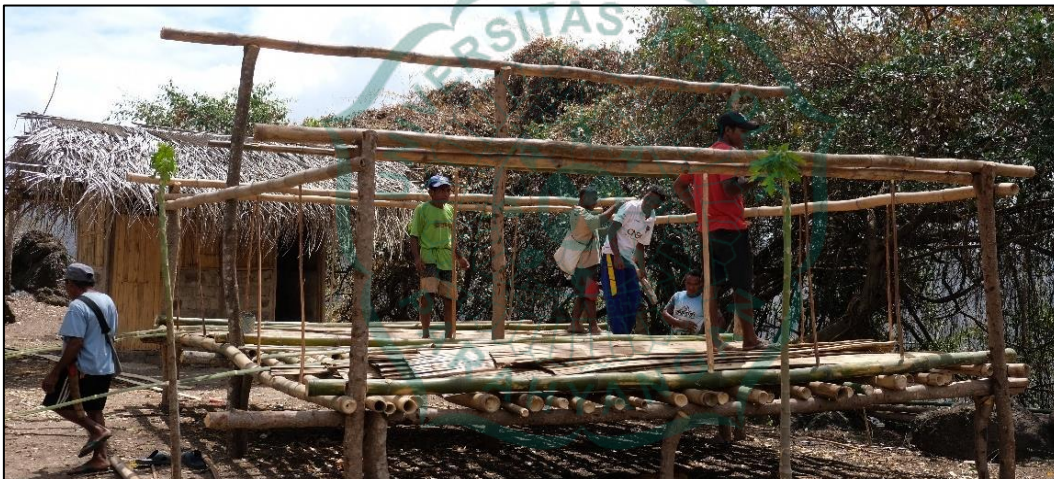
Gambar 1.3 Pembangunan Sa'o Tingkat 1 Kampung Boamara
