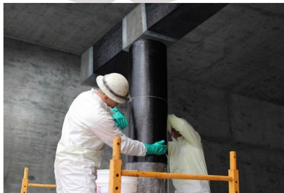
Gambar 1.1 Pemasangan CFRP pada kolom
