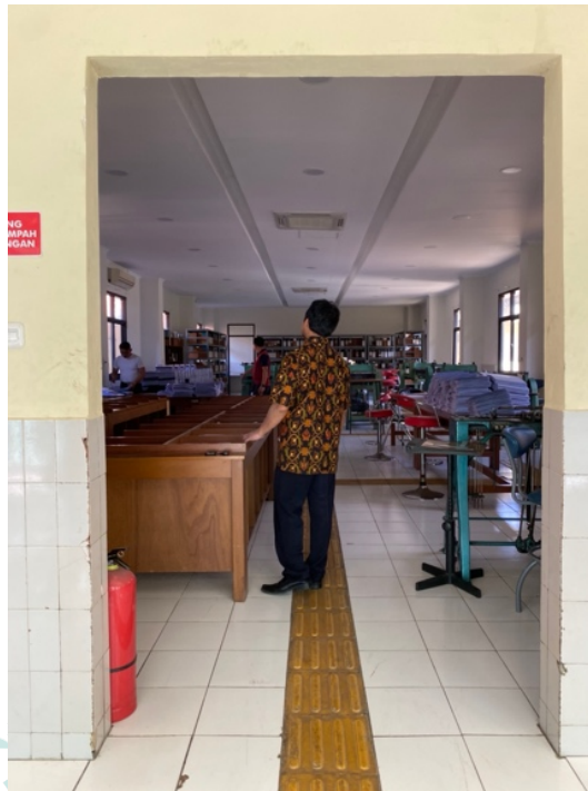
Jalur Pemandu Pada Ruang Percetakan (Bangunan 5)
