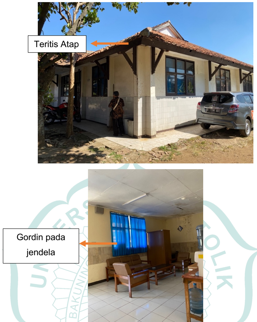
Gambar 5.12 Teritis dan Gordin Pada Bangunan Sentra (Bangunan 8)
