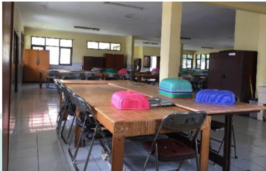
Gambar 5.16 Kondisi Ruang Makan Sentra Wyata Guna (Bangunan 4)
