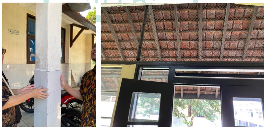
Gambar 5.21 Struktur Bangunan Sentra (Bangunan 8 dan 3)
