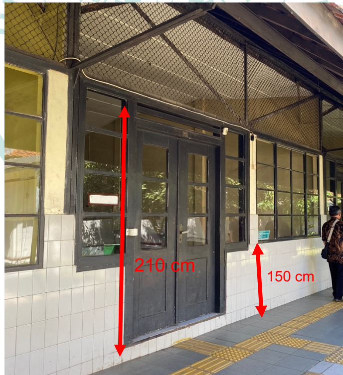
Gambar 5.29 Kenyamanan Ruang Gerak Vertikal (Bangunan 3)
