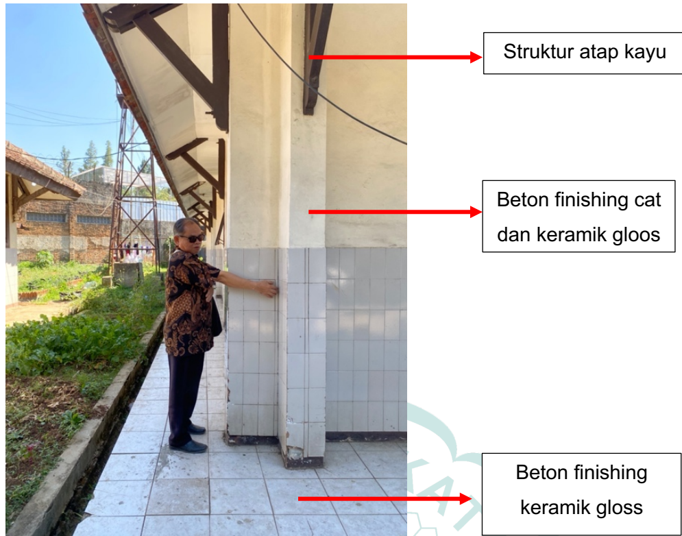
Gambar 5.27 Material Pada Bangunan Sentra (Bangunan 8)
