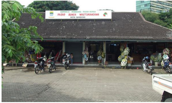
Gambar 1. 2 Bangunan Pasar Bunga Wastukencana
