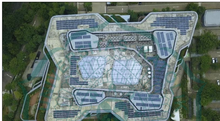
Gambar 1.3 Panel Surya pada Atap Bangunan Grha Unilever (Sumber : Youtube Ditjen EBTKE 3 Mei 2021)
