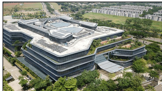
Gambar 1. 2. Solar Panel pada bangunan GRHA Unilever (Sumber : Green Building Council Indonesia )
