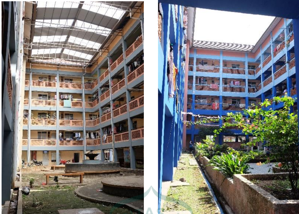
Gambar 1.2 Area Terbuka Pada Blok Massa 1 dan 3
