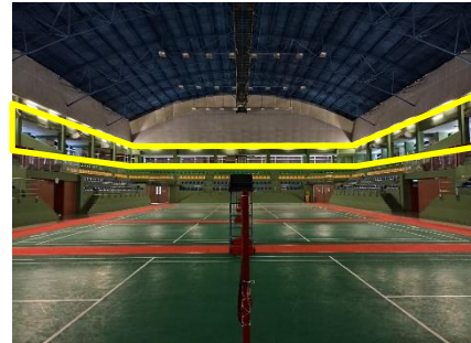
Gambar 1.2 Lapangan Indoor GOR Koni Eksisting posisi bukaan samping atas
