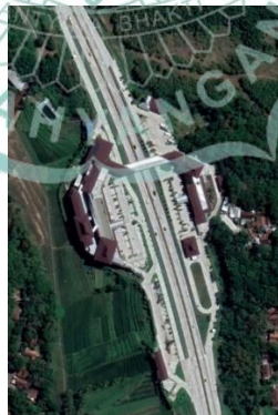
Gambar 1.2 Lokasi Rest Area Pendopo km 456 Sumber: google earth
