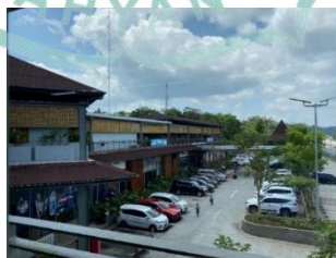
Gambar 1.3 Bangunan Rest Area Resta Pendopo 456 A Sumber : dokumentasi pribadi
