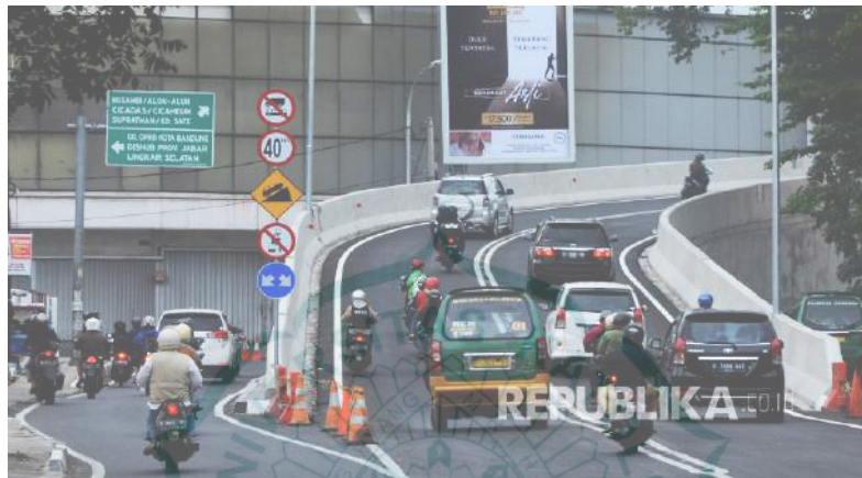
Gambar 1.2 Overpass Jl. Jakarta - Jl. Supratman Sumber : https://republika.co.id (diakses 4 Maret 2022)
