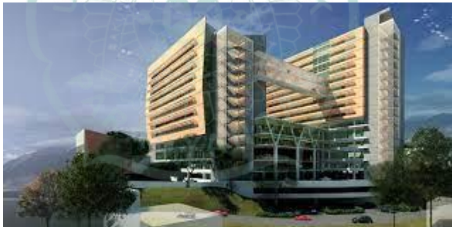
Gambar 1.1 Gedung PPAG Baru
