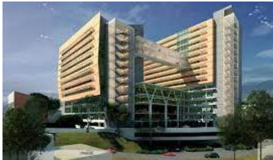
Gambar 1.2 Gedung PPAG UNPAR Sumber : Unpar.ac.id
