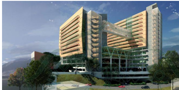
Gambar 1.1 Gedung PPAG 2 UNPAR
