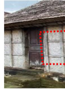
*Gambar 6.39. Susunan Bambu Penutup Bangunan Arsitektur Paon Rumah Nyoman Tandre.*
