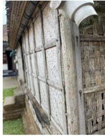
*Gambar 6.11. Susunan Bambu Penutup Dinding Bangunan Arsitektur Paon Rumah Wayan Supat
