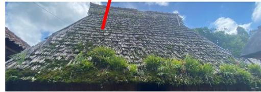
Gambar 6.37. Susunan Bambu Penutup Atap Bangunan Arsitektur Paon Rumah Nyoman Tandre.
