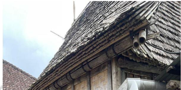
Gambar 6.10. Susunan Bambu Penutup Atap
