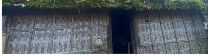
*Gambar 6.38. Susunan Bambu Penutup Bangunan Arsitektur Paon Rumah Nyoman Tandre.*
