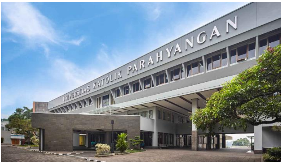
GAMBAR 1.5 GEDUNG REKTORAT UNIVERSITAS KATOLIK PARAHYANGAN
