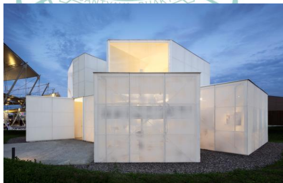
Gambar 1.3. Paviliun sebagai ruang galeri (Piuarch) Sumber: Archdaily
