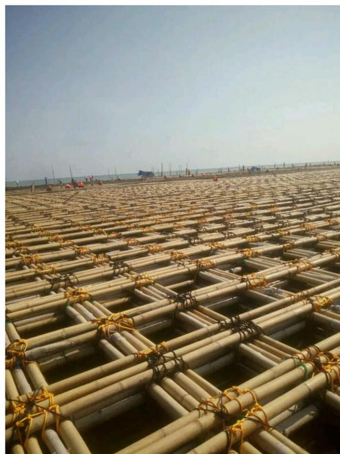
Gambar I.1 Konstruksi Matras Bambu
