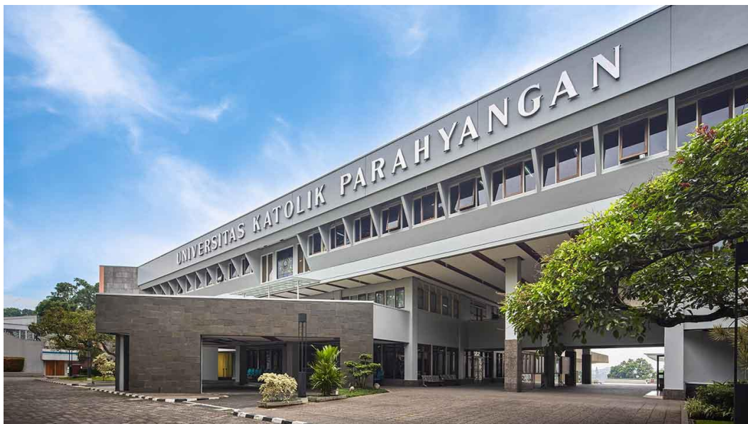
Gambar 1.6. Gedung Universitas Katolik Parahyangan
