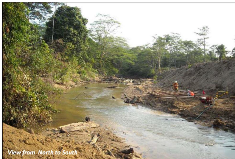
Gambar 1. 1 Kondisi Awal Sungai Lembak (PT Montraco Internusa, 2009)
