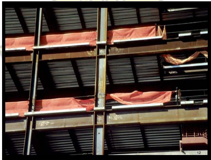
Gambar 1.5 Rangka Pemikul Momen yang Terhubung dengan Rangka Tegak Lurus
