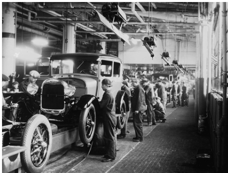
Gambar 2: Lini produksi mobil Ford model-T. [5]
