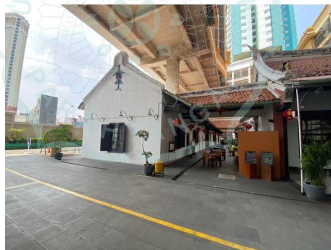
Gambar 1. 4 Sayap Bangunan Gedung Candra Naya setelah direvitalisasi
