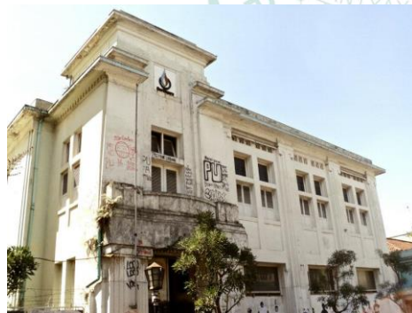
Gambar 1. 4 Gedung Gas Negara Sebelum dialihfungsikan Sumber: Google Images
