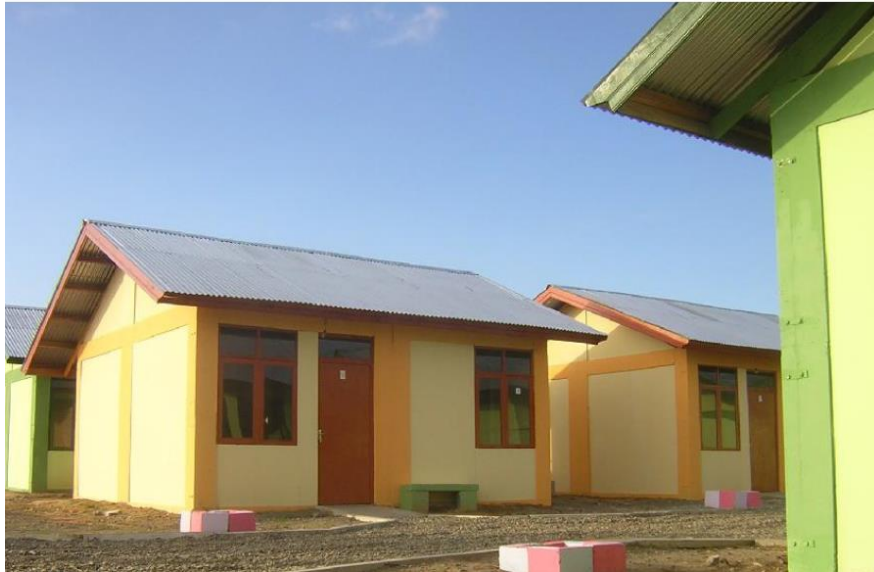
Gambar 1. 3 Contoh Rumah RISHA (Sumber: Kementerian Pekerjaan Umum dan Perumahan Rakyat, 2015)
