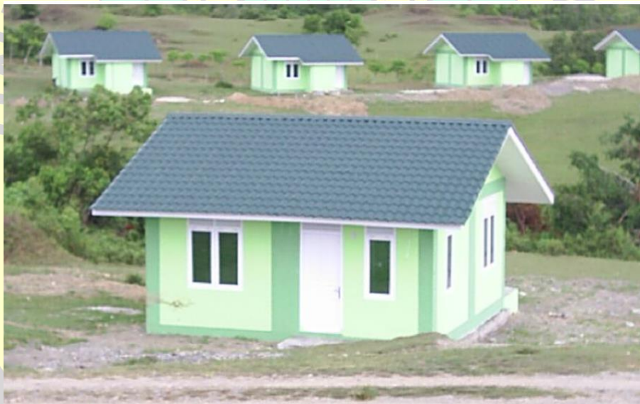
Gambar 1. 4 Rumah Transmigrasi di Aceh (Sumber: Kementerian Pekerjaan Umum dan Perumahan Rakyat, 2015)
