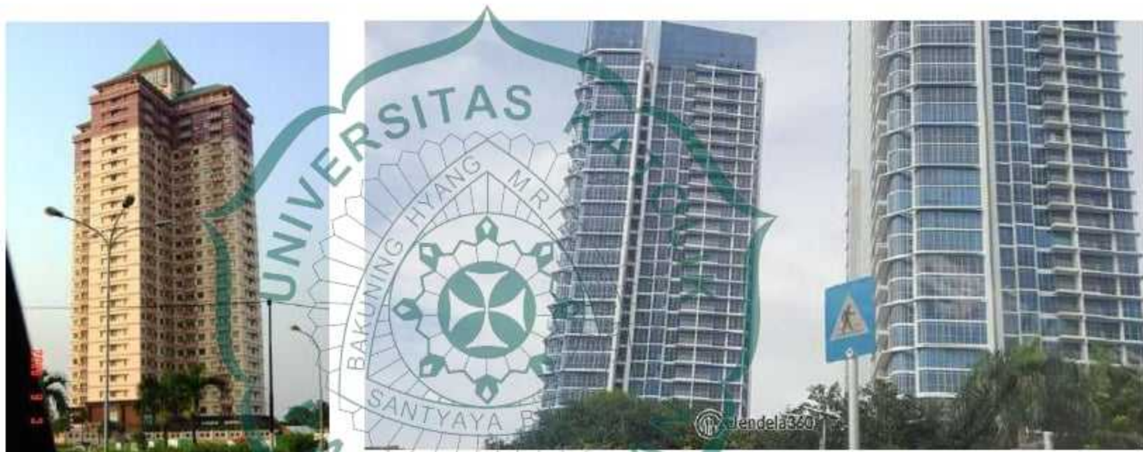
Gambar 1.1 perbandingan fasad bangunan tinggi (sumber: google.com)
